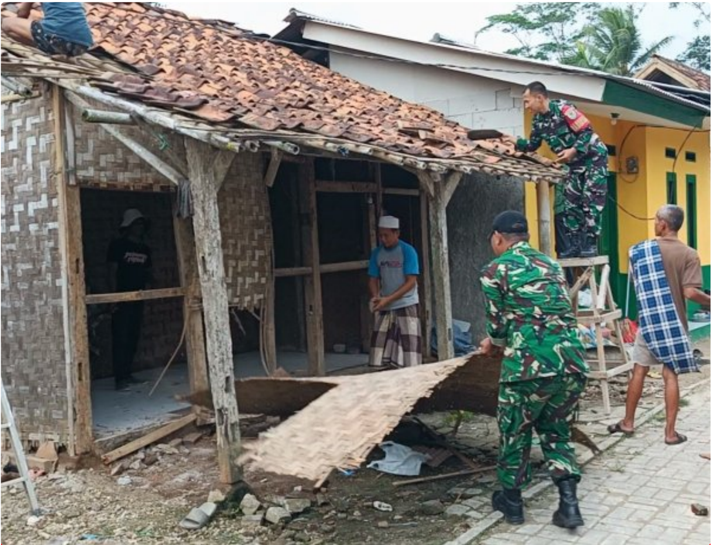
Pembongkaran Rumah Bapak Narmin
